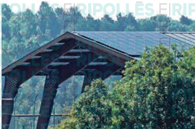
Hi ha 27 plaques a cada vessant de la coberta
