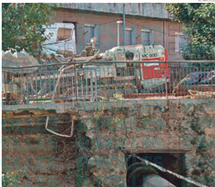
Imatge dels darrers treballs de reparació que ja es van efectuar
