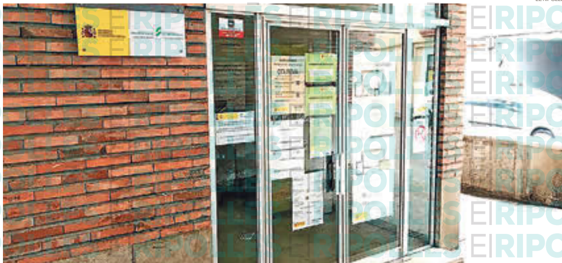
Imatge d'arxiu de l'edifici de la Seguretat Social a Ripoll
