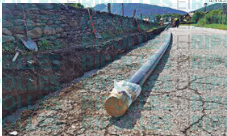
Llanars ja va fer obres al clavegueram, fa dos anys
