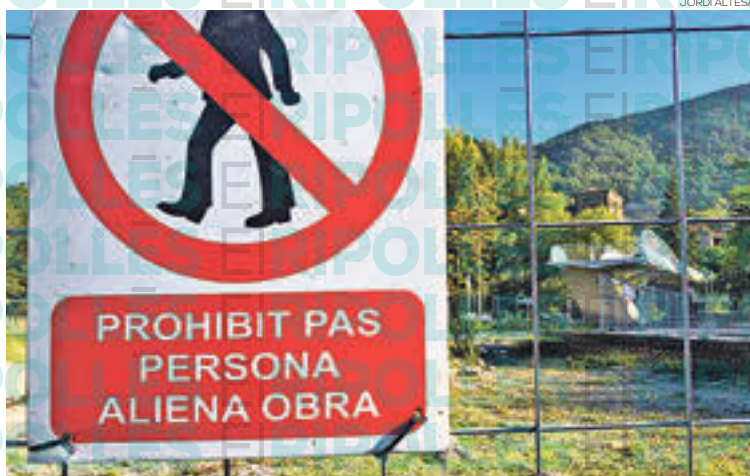
Les obres del pont de Ripoll, a la zona de la Devesa del Pla
