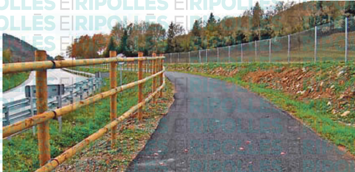
Obres de la via verda a Sant Pau de Segúries
