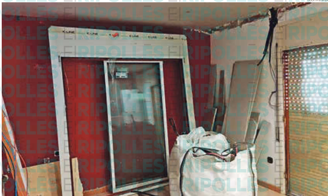
Un pis on s'estan realitzant obres de rehabilitació
