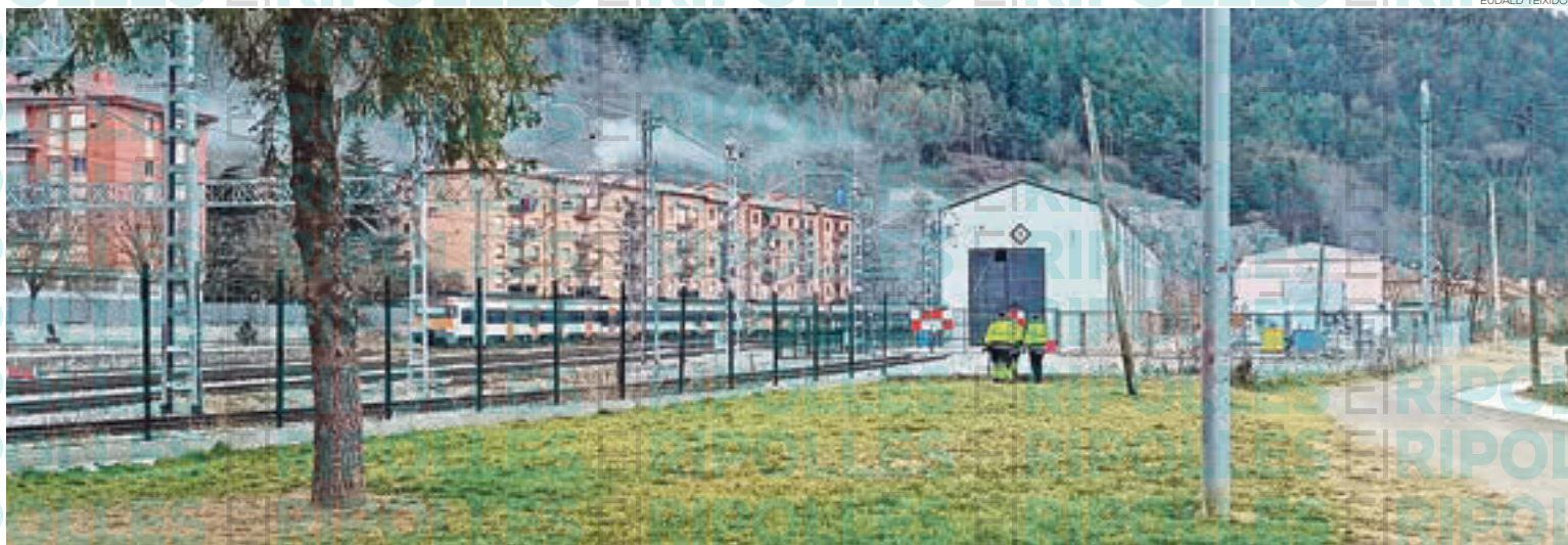
La base de manteniment provisional d'Adif a Ripoll
