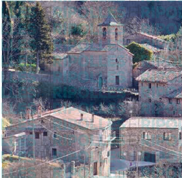
Les captacions milloraran els nivells d'aigua als dipòsits
