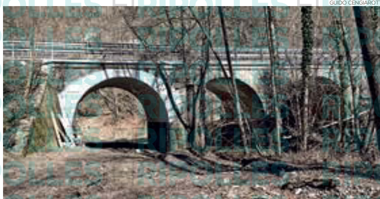
Pont de la riera de Vilardell
