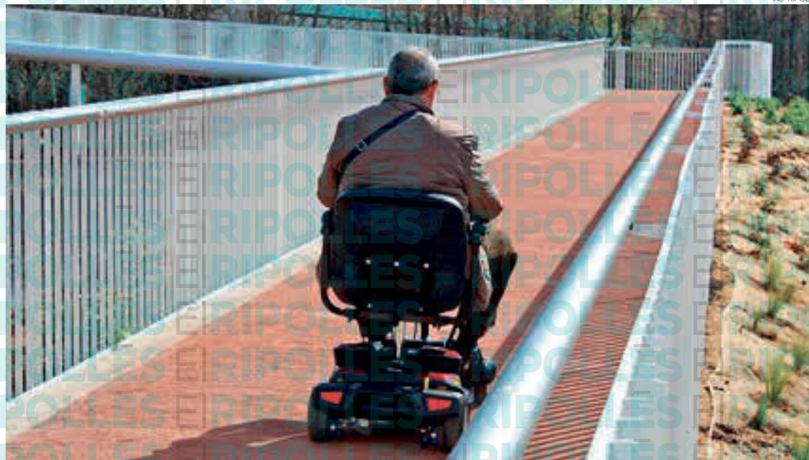
El primer vilatà a estrenar la nova rampa del pont de Calatrava
