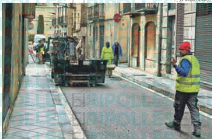
Obres d'instal·lació de la fibra òptica al carrer del Prat
