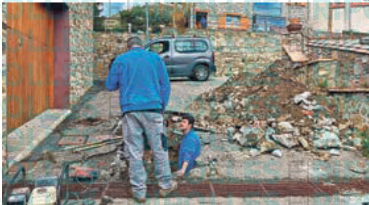
Les obres s'han dut a terme al carrer de l'Església
