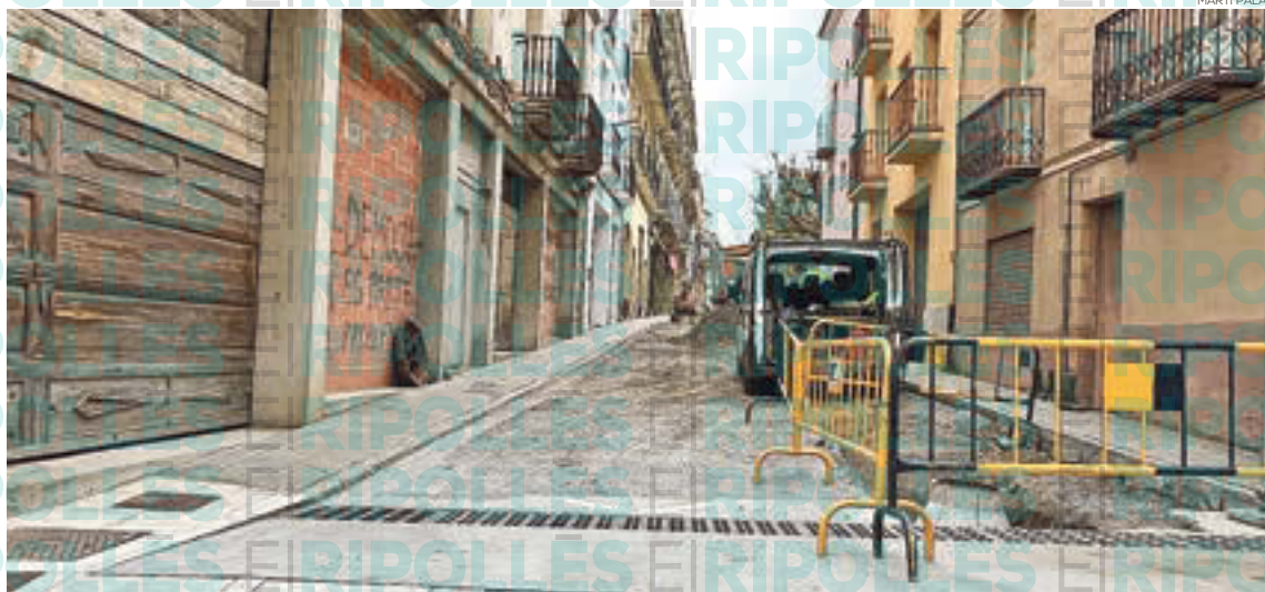
Les obres de reurbanització de la plaça Clavé ja estan en marxa
