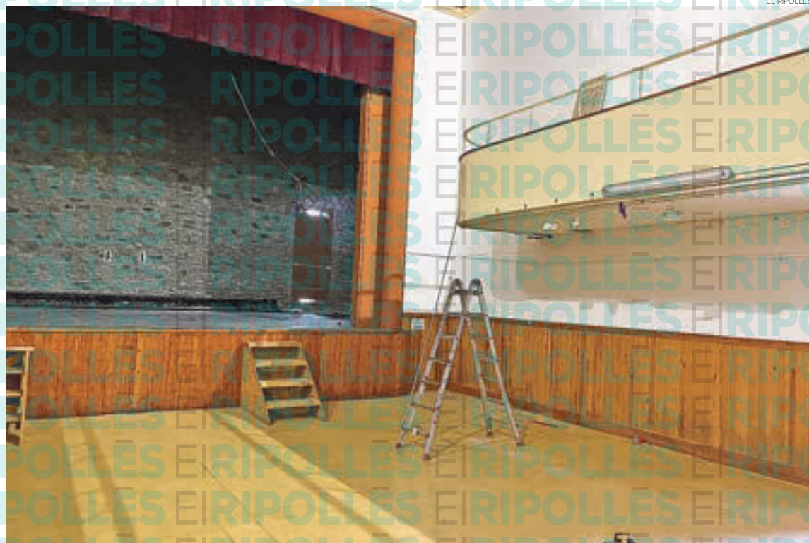
Obres al casino de Planoles
