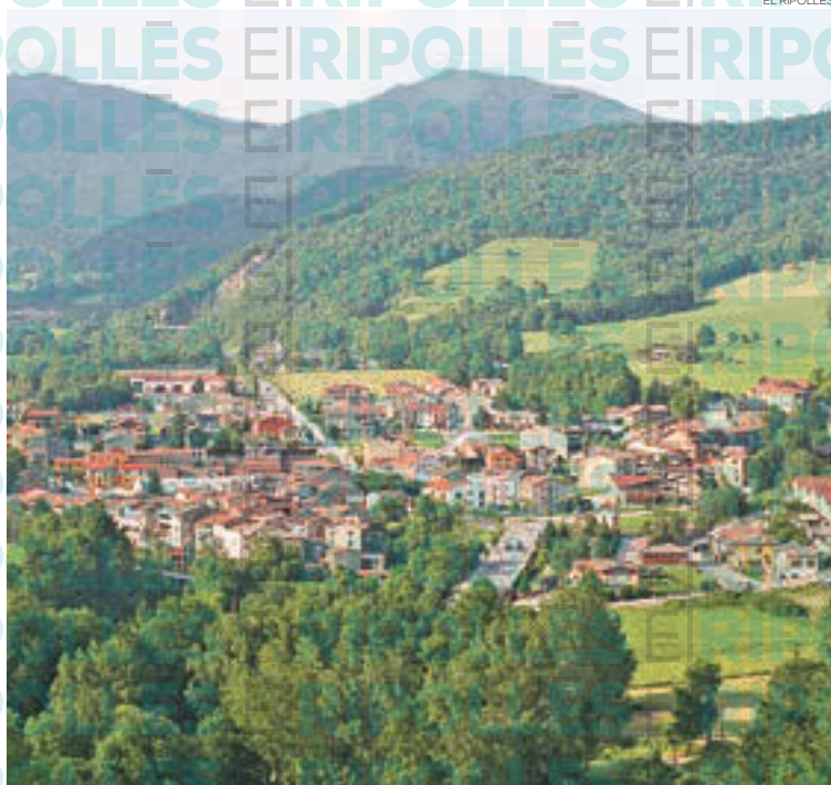
Vista aèria de Sant Pau de Segúries
