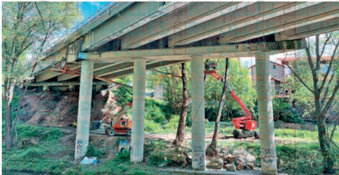
Imatge de les obres que ja s'estan duent a terme per reparar el viaducte
