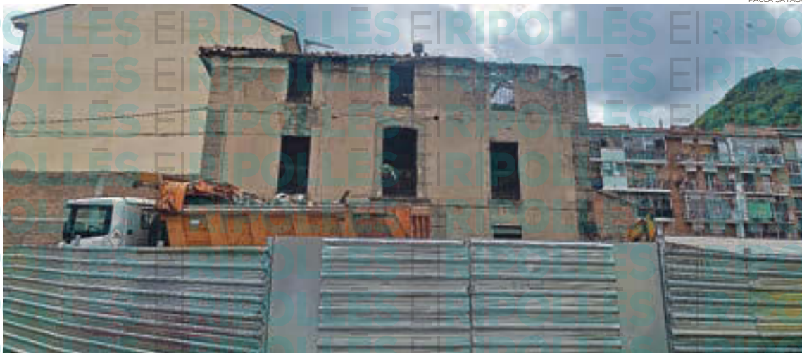
La rehabilitació de la finca de la Torre de Ripoll, un dels projectes que és possible gràcies a fons europeus
