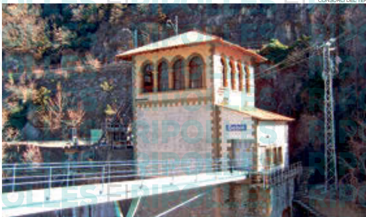
La central de la Cúbia, al límit entre el Ripollès i Osona
