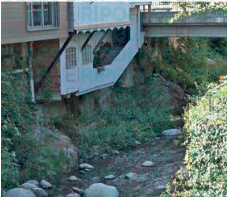
Els murs dels edificis arran del Freser a Ribes
