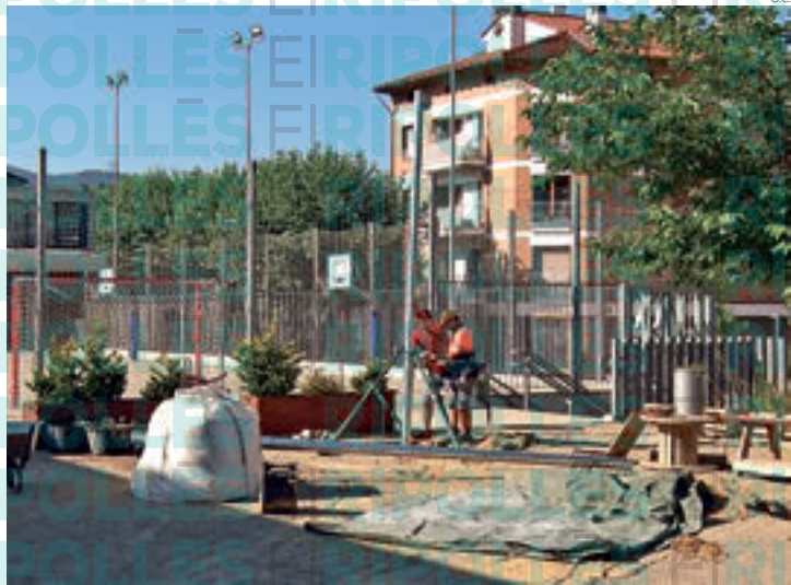
Imatges de la instal·lació i les obres
