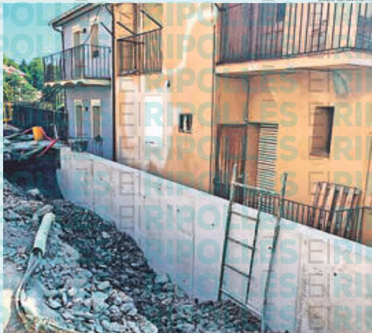
Les obres del mur del Pla del Roser
