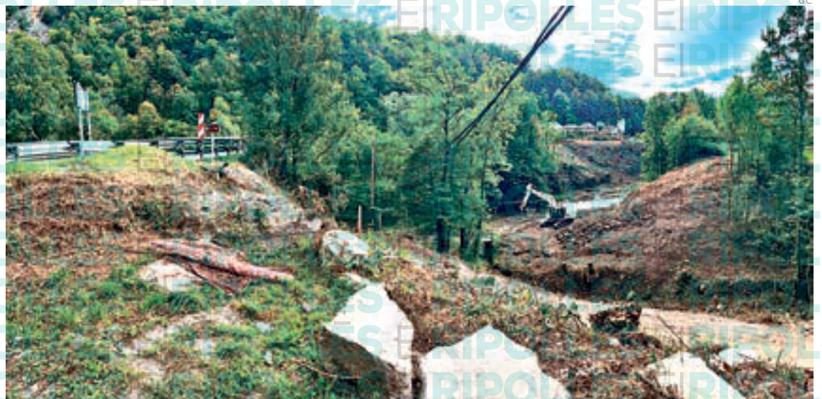
Estat actual de les obres, començades ara fa pocs dies
