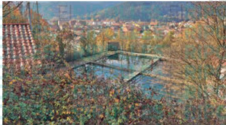
L'Estació de Tractament d'Aigua Potable
