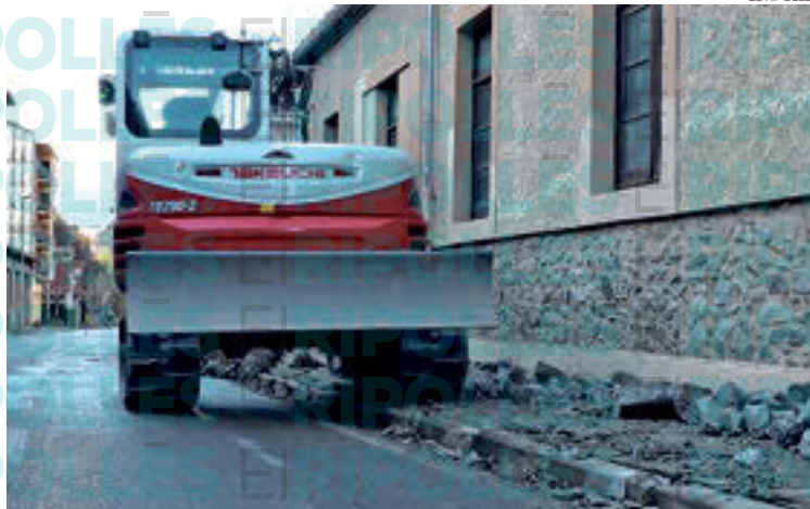
La primera fase de les obres ja ha començat
