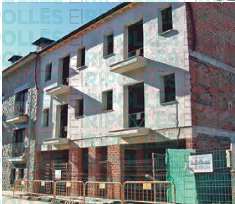
Construcció d'habitatges a Sant Pau de Segúries
