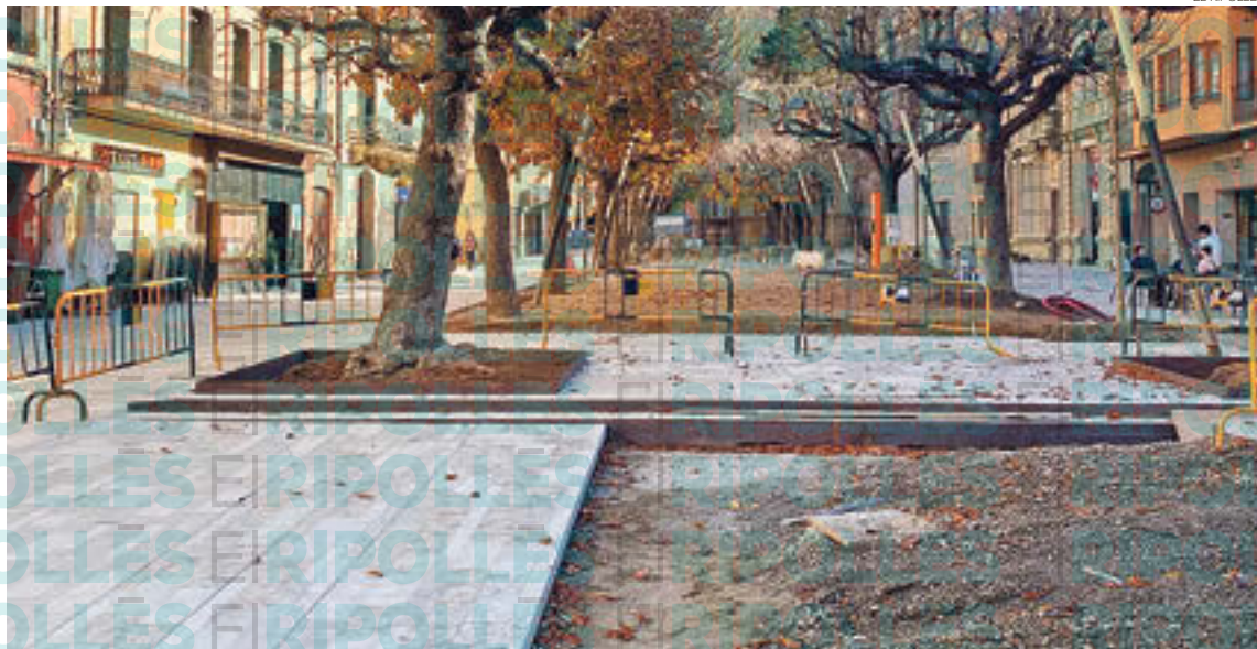
Les obres al passeig Comte Guifré de Sant Joan
