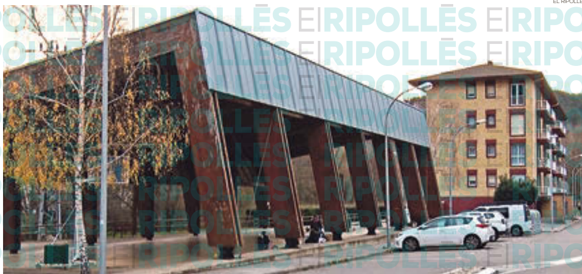
Es volen posar plaques fotovoltaïques a la pista poliesportiva
