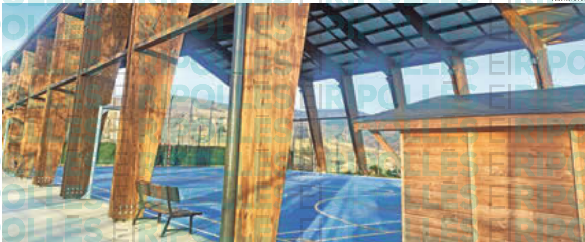
Imatge de la pista poliesportiva on es troba la instal·lació fotovoltaica
