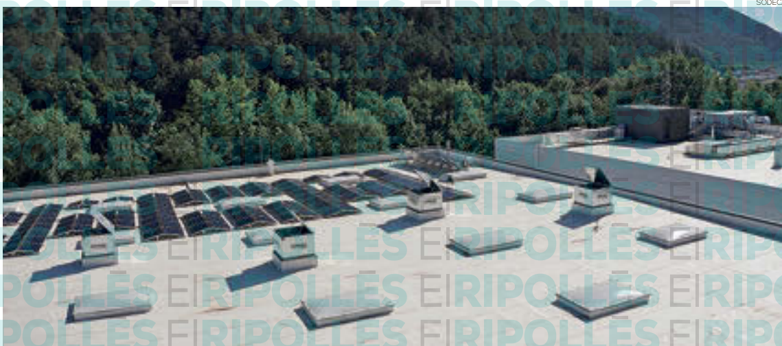
Instal·lació de plaques solars al centre de producció de Ripoll
