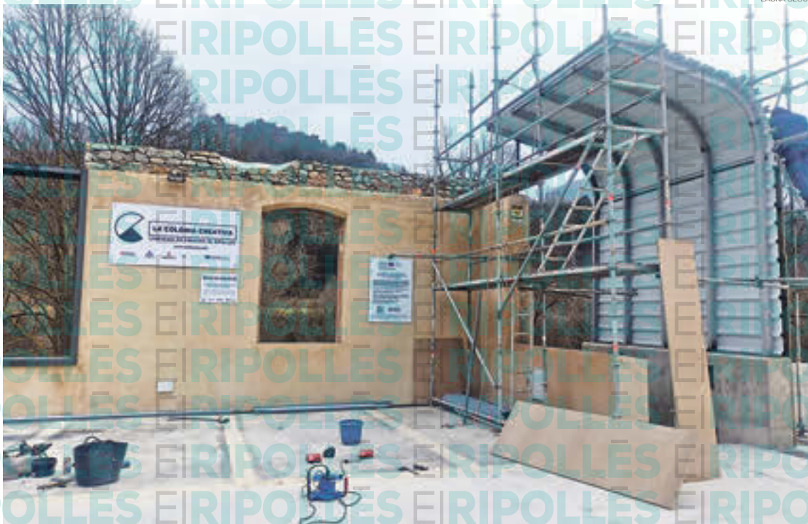
Imatge de les actuacions que s'estan duent a terme per a la instal·lació de la marquesina de l'equipament
