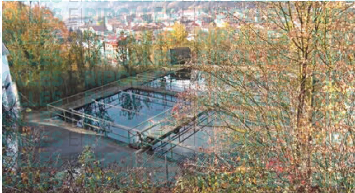
L'Estació de Tractament d'aigua potable, a Campdevàrol
