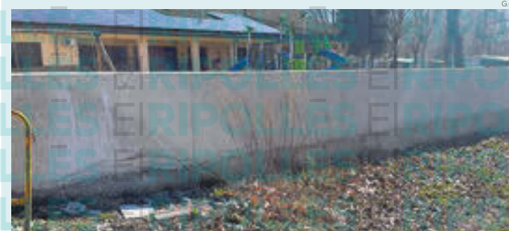
El tram de mur construït
