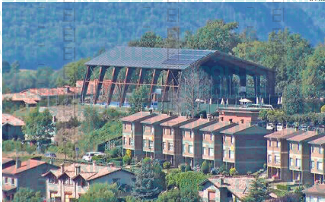
Imatge de la coberta de la pista poliesportiva de Molló, on hi ha les plaques
