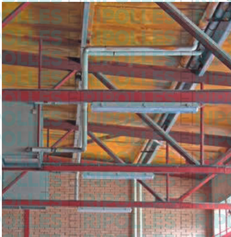
La coberta -des de l'interior- del Pavelló Municipal de Ripoll
