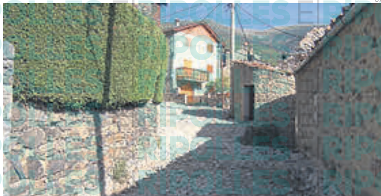
Obres al carrer Major de Planès el 2022
