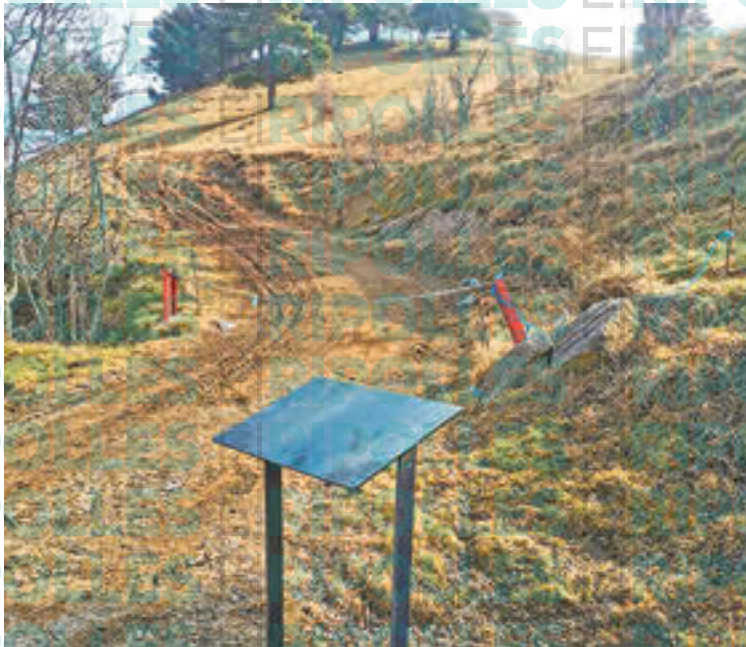
Els plafons ja han començat a ser instal·lats al llarg del camí
