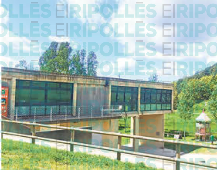
Les plaques estarien ubicades al sostre de la sala polivalent
