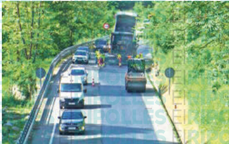
Fins la setmana que ve es reasfaltarà la N-260 entre Ribes i Campdevànol
