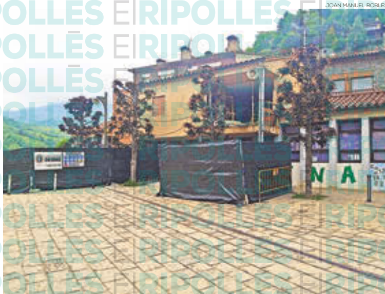
L'escola de Vilallonga, en obres
