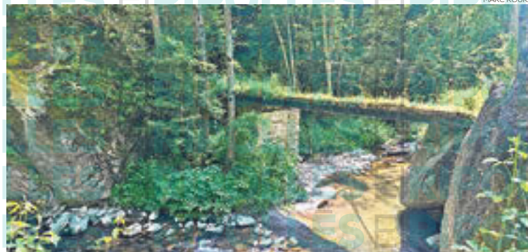
Pont de Coma
