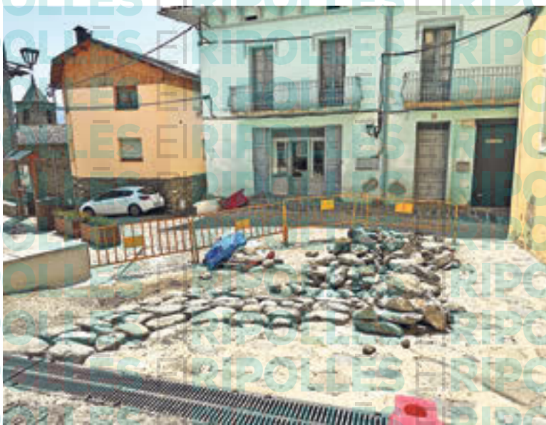
Obres als carrers de Planoles
