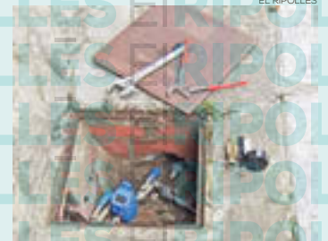
Substitució dels comptadors a Gombrèn
