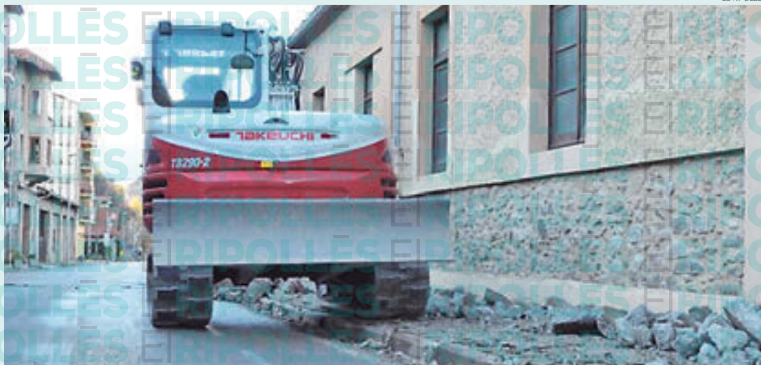
Treballs de la primera fase de la carretera
