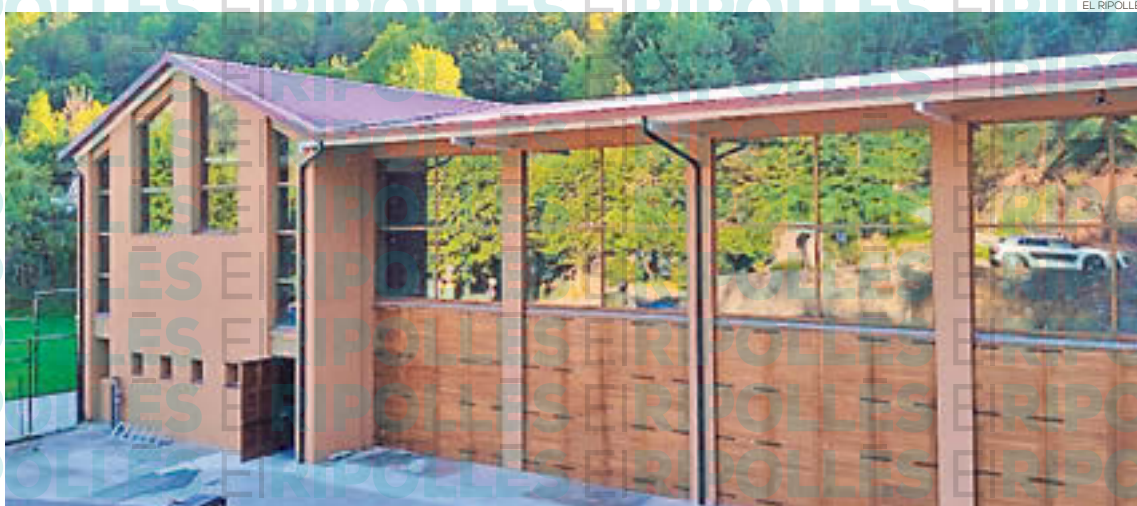
Coberta del pavelló d'Ogassa
