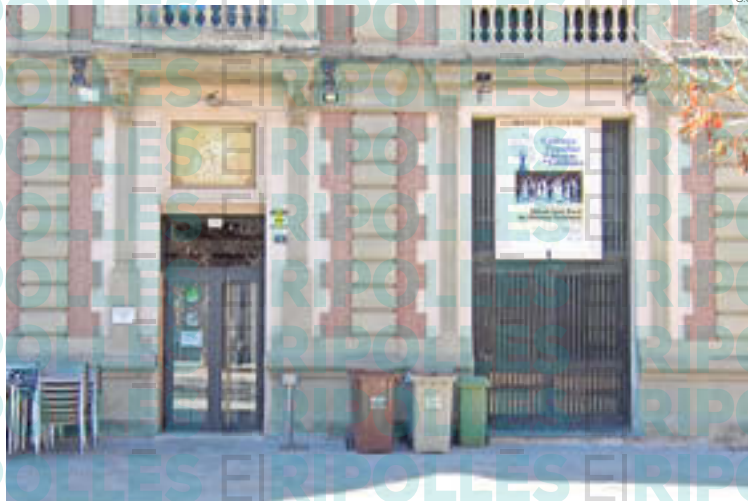
Façana del SAT Teatre Centre, al passeig Comte Guifré
