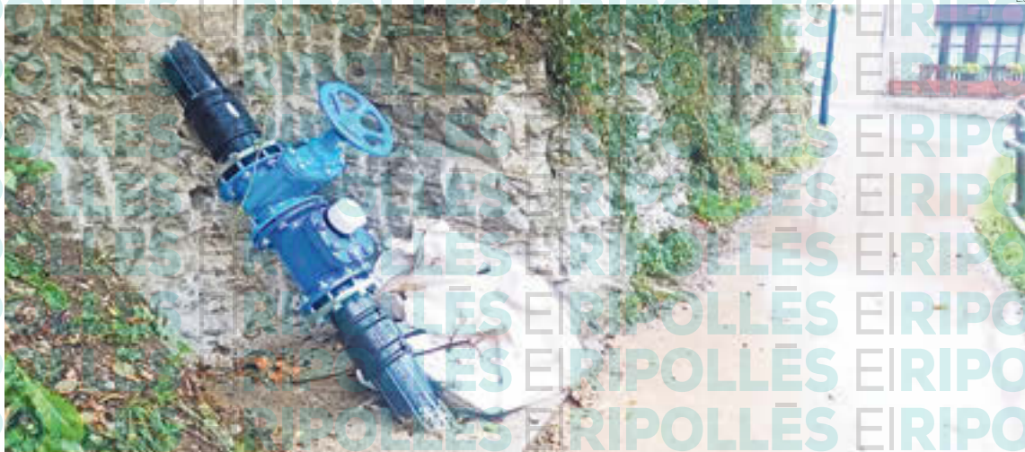
Imatge de nova canonada a Gombrèn
