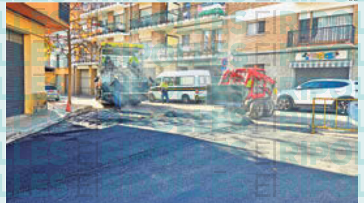
Asfaltatge al carrer Sant Josep de Calassanç
