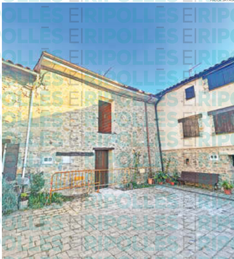
L'antiga caserna de Vallfogona, encara en obres
