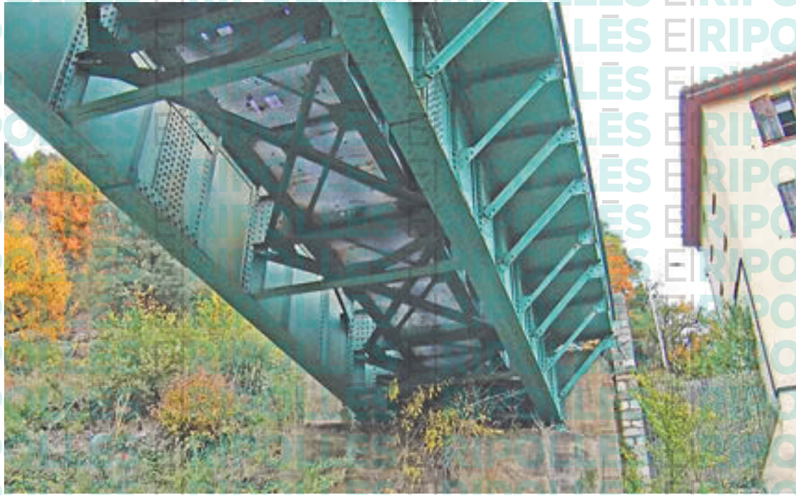
Un pont ferroviari a la Farga de Bebié
