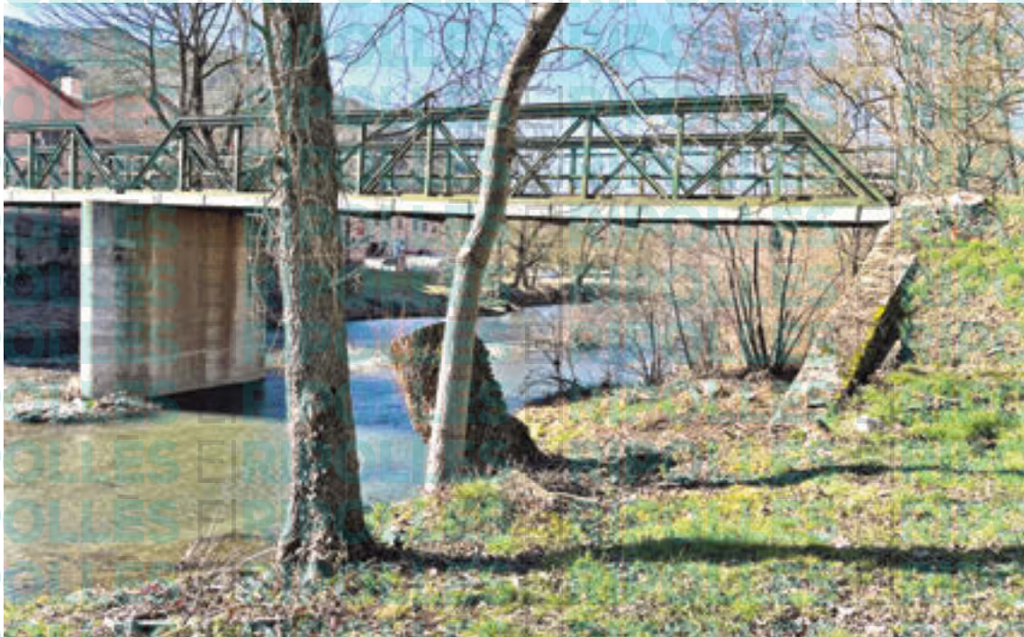
La zona on es volen construir les motes i els murs, en el pas del riu davant la Fibran, a la Colònia de Cal Gat
