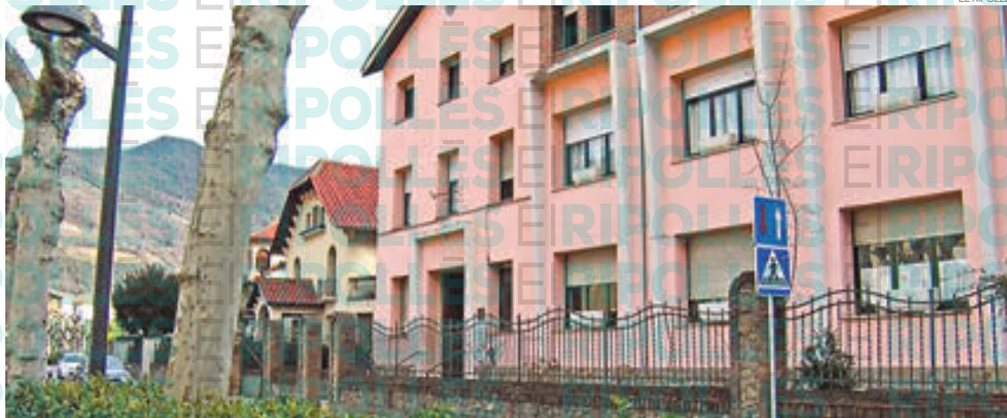
La residència geriàtrica de Ribes de Freser compta ja amb la nova caldera de gasoil
