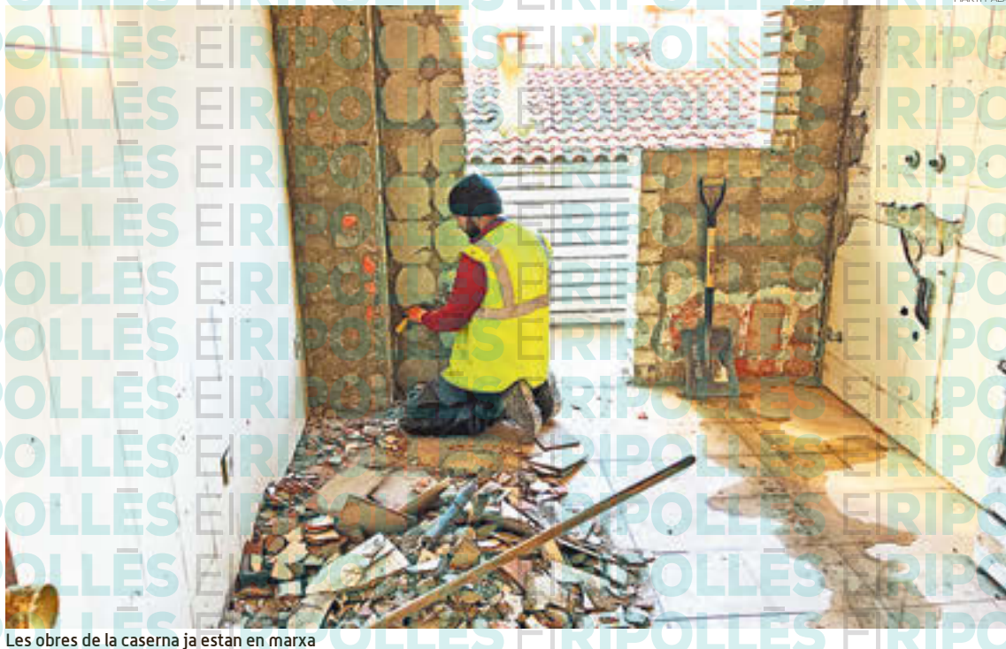
Les obres de la caserna ja estan en marxa
