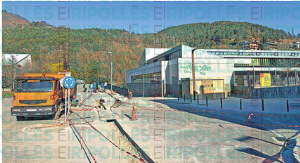
Obres d'ampliació de la xarxa de calor de l'Escola Pirineu i la Sala Diagonal de Campdevàrol
