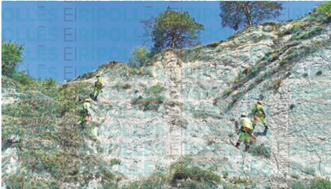
Els operaris estan fent treballs en vertical a tota la paret del talús
