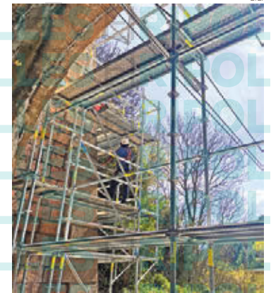
S'estan instal·lant les bastides per poder actuar en l'estat d'aquest element
