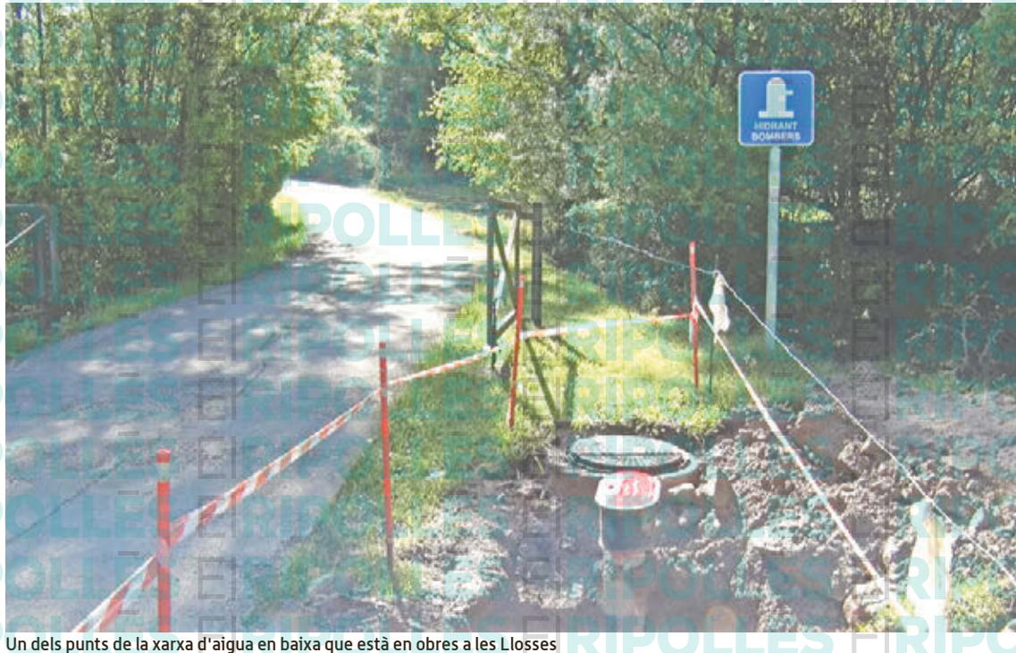
Un dels punts de la xarxa d'aigua en baixa que està en obres a les Llosses
