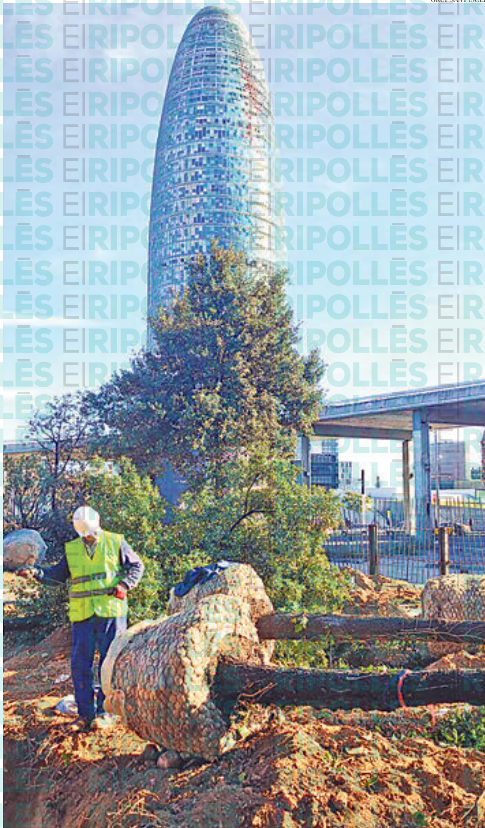
Trasplantament de 236 alzines i el roure que hi ha al centre de la plaça de les Glòries de Barcelona i transport al viver provisional per a permetre que es duguin a terme les obres de transformació d'aquest espai. Trasplantament de Quercus ilex.
