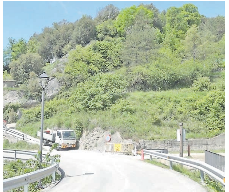
Obres al clavegueram de Gombrèn
