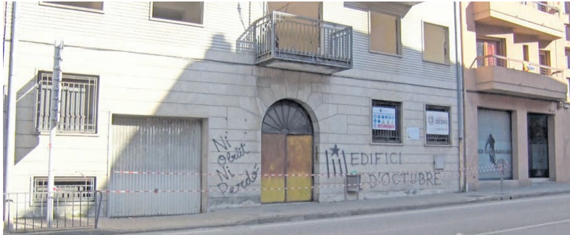
L'antiga caserna, actualment en reformes
