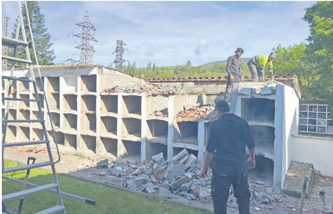
Els operaris ja treballen per rehabilitar el cementiri
