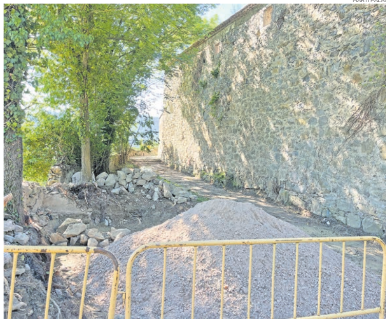
La zona d'obres del cementiri municipal de Campdevàrol
